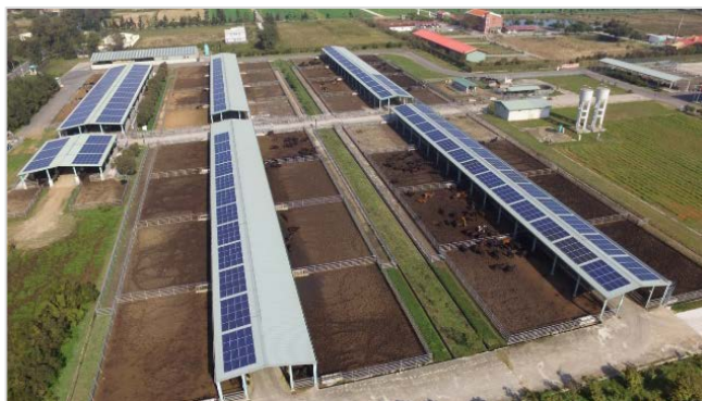
圖 8、公有屋頂設置太陽能光電系統
