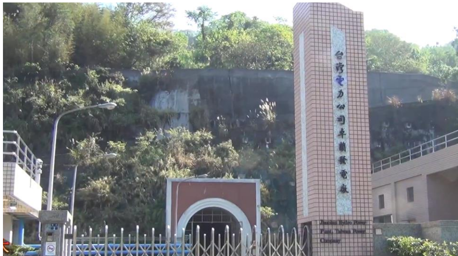
圖 1.10-2 苗栗卓蘭水力發電廠
