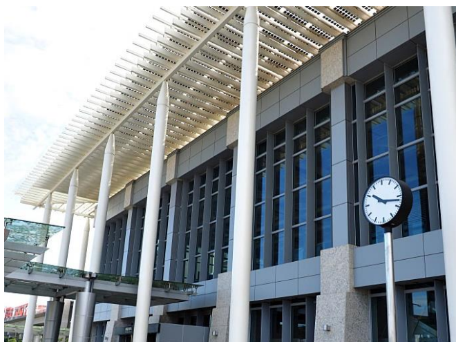
圖 1.10-8 綠建築高鐵苗栗站
