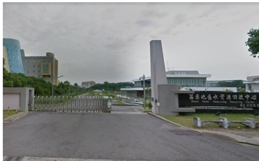
圖 1.10-7 苗栗地區水資源回收中心
