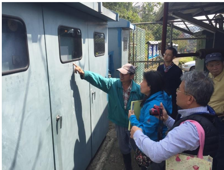
圖 1.10-4 機關現場輔導情形
