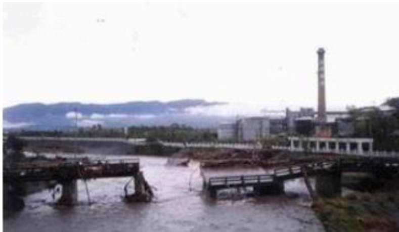
圖 4 社區橋墩受土石流衝擊毀斷
